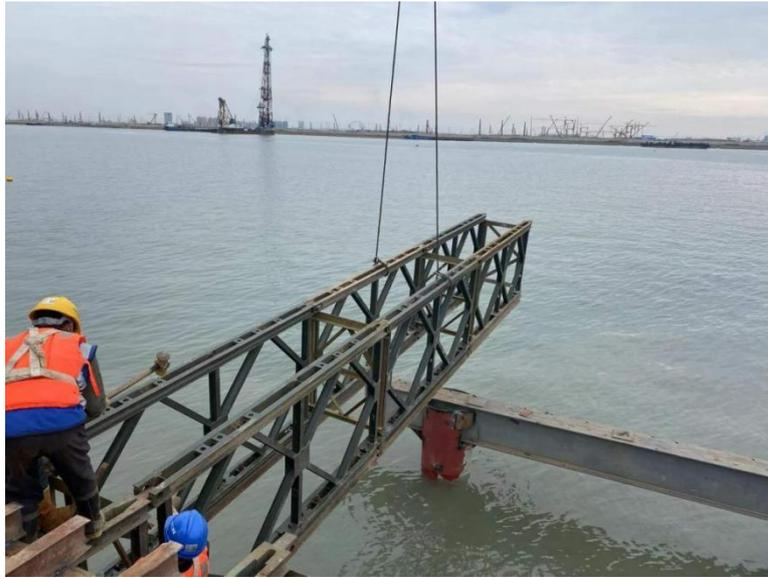
图 2-21 贝雷片拆除吊装
