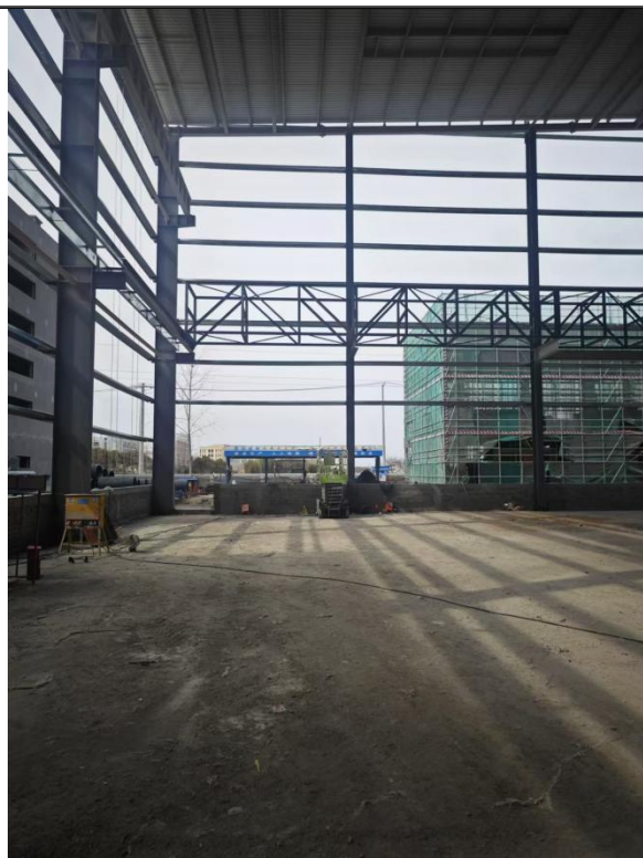
1#~4#装置拟建址西侧 (N 系列吹膜车间内场所)
